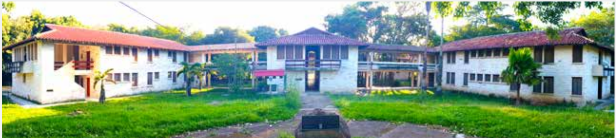
1 Complejo residencial en proceso de remodelación. One residential complex under renovation.
